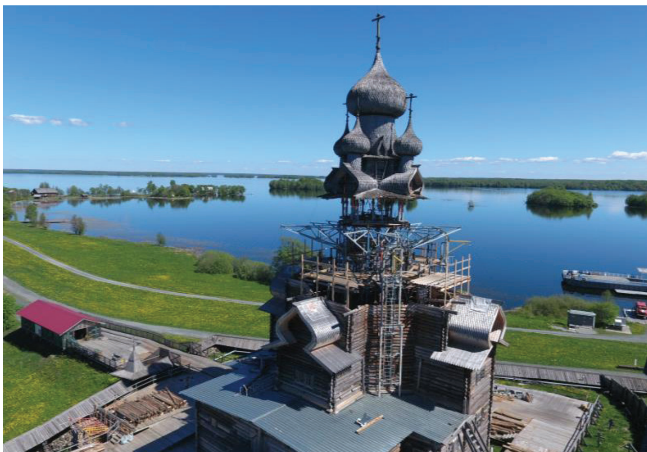
Рис. 13. Преображенская церковь. Демонтирован 1-й реставрационный пояс. Смонтированы металлические кронштейны
