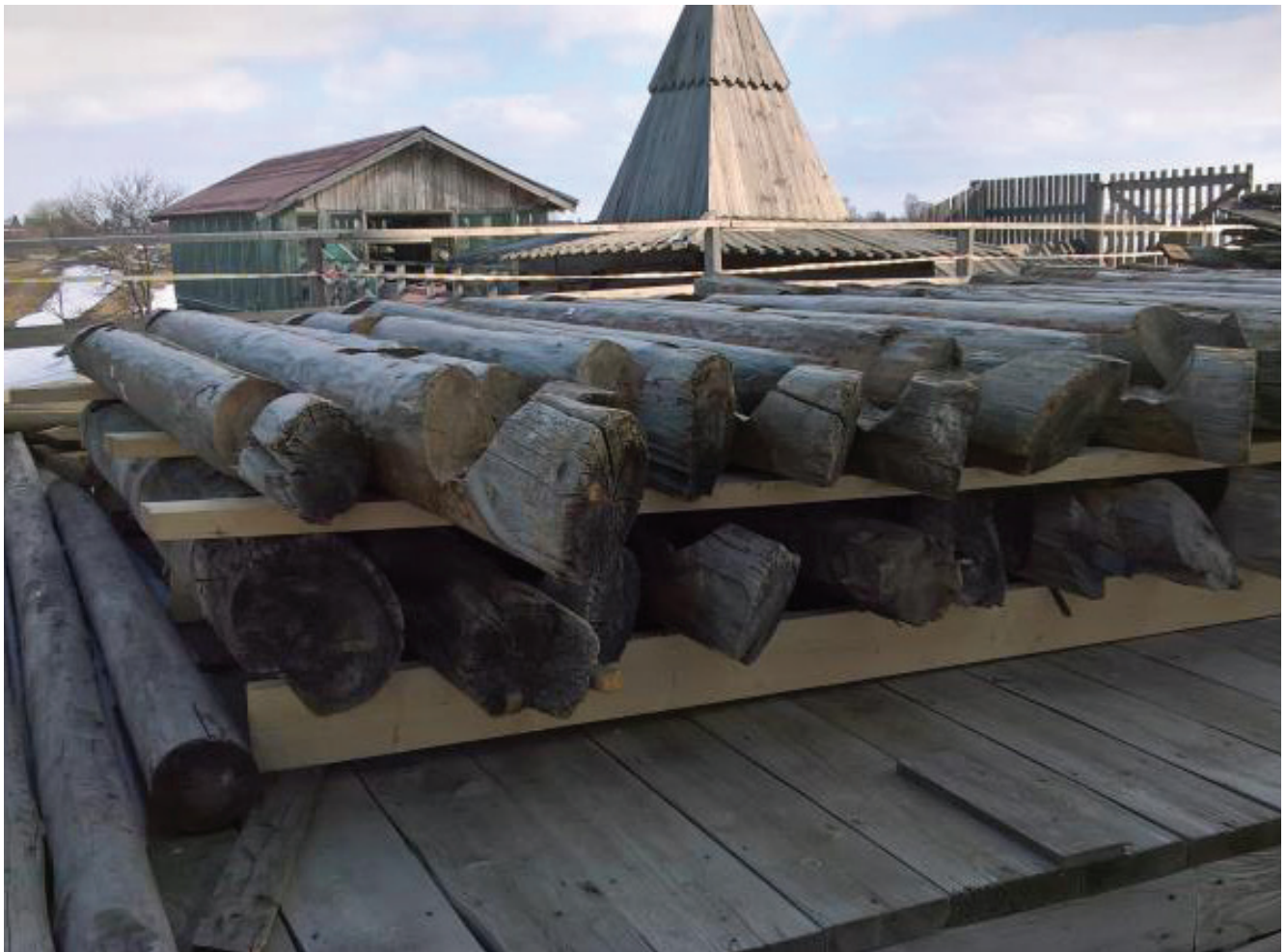
Рис. 11. Демонтированные элементы сруба 2-го реставрационного пояса
