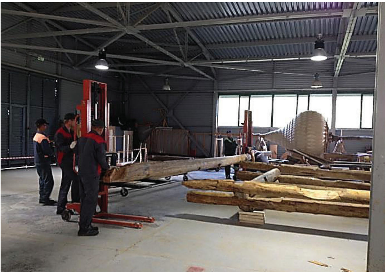
Рис. 25. Реставрационная сборка сруба 2-го реставрационного пояса в цехах
