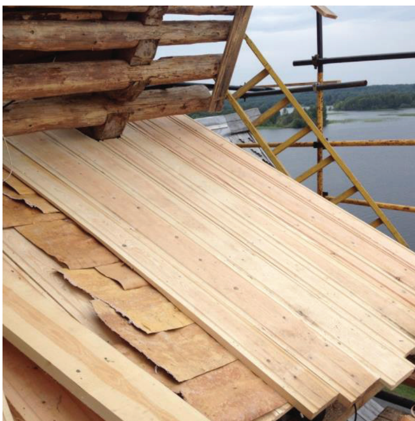
Рис. 35. Окрытие полиц 3-го реставрационного пояса (укладка теса и берестяной гидроизоляции)
