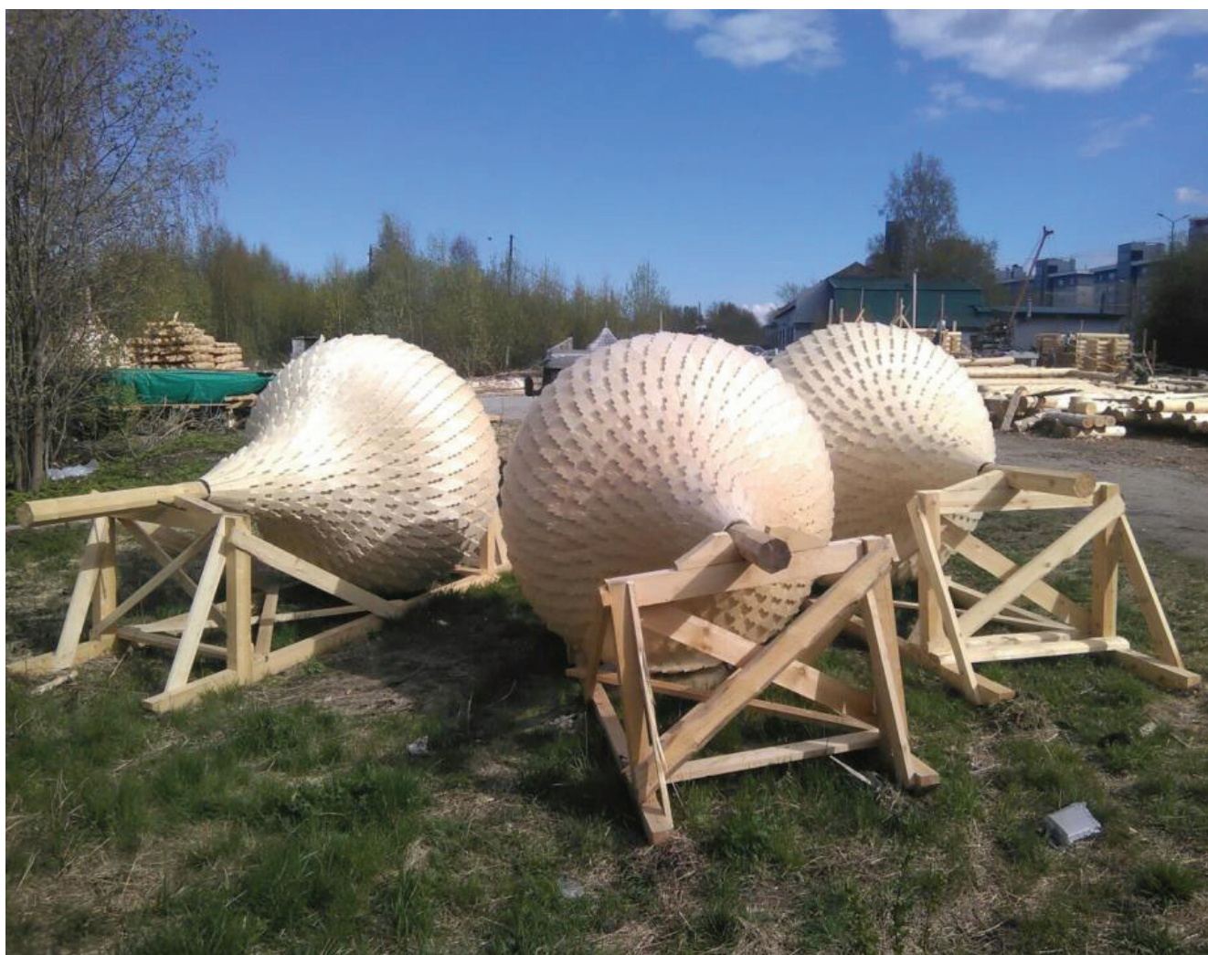
Рис. 31. Отреставрированные главки 2-го реставрационного пояса
