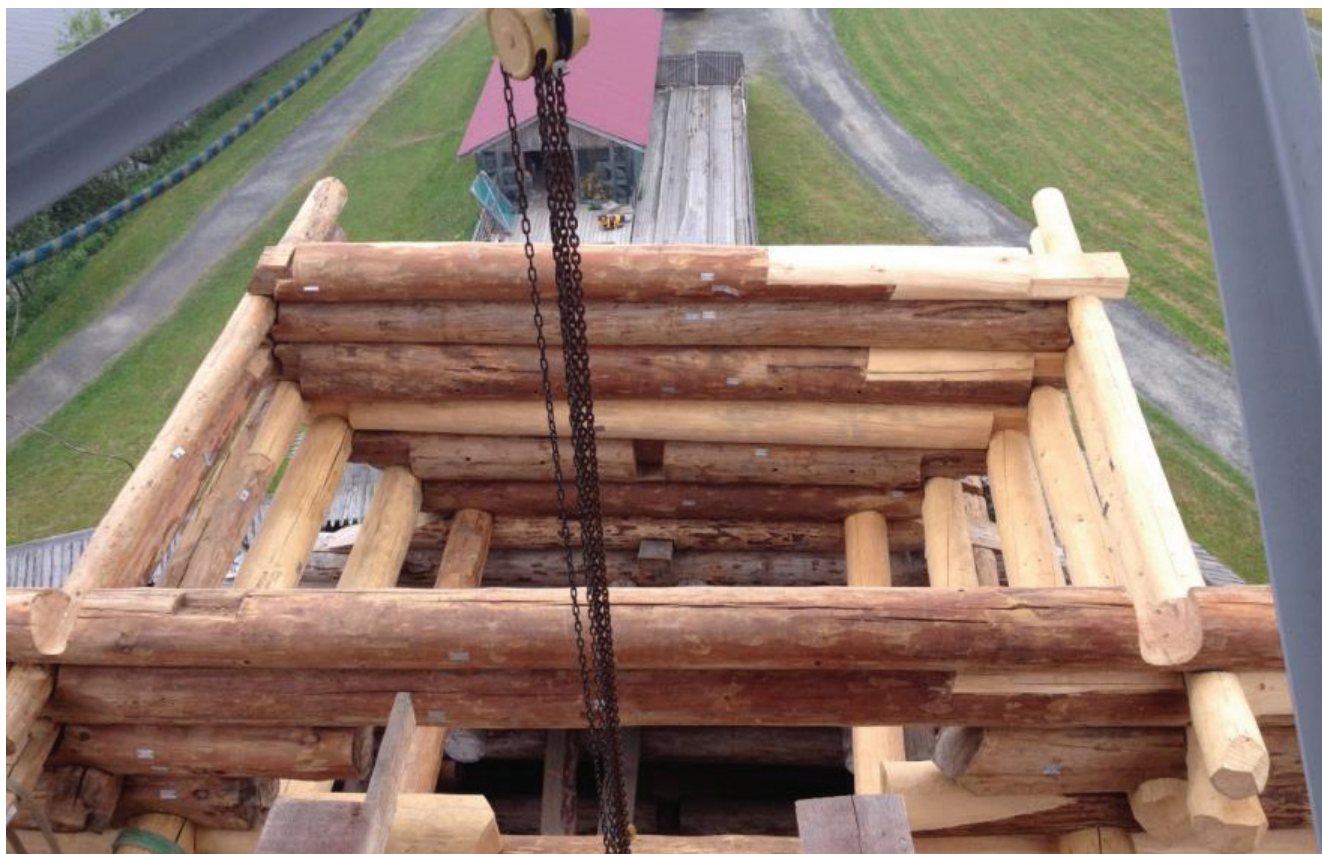
Рис. 22. Сборка сруба 3-го реставрационного пояса на погосте. Северный прируб
