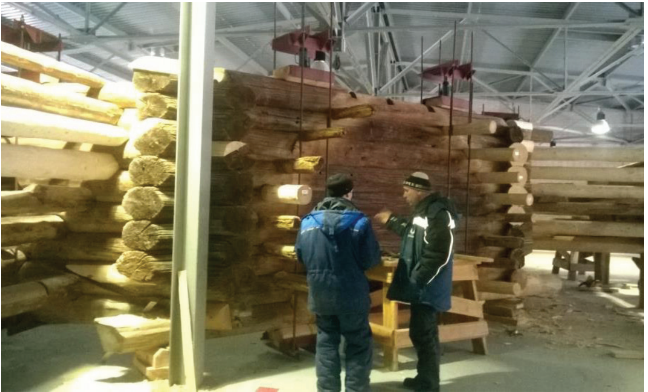
Рис. 20. Обжатие части сруба 3-го реставрационного пояса
