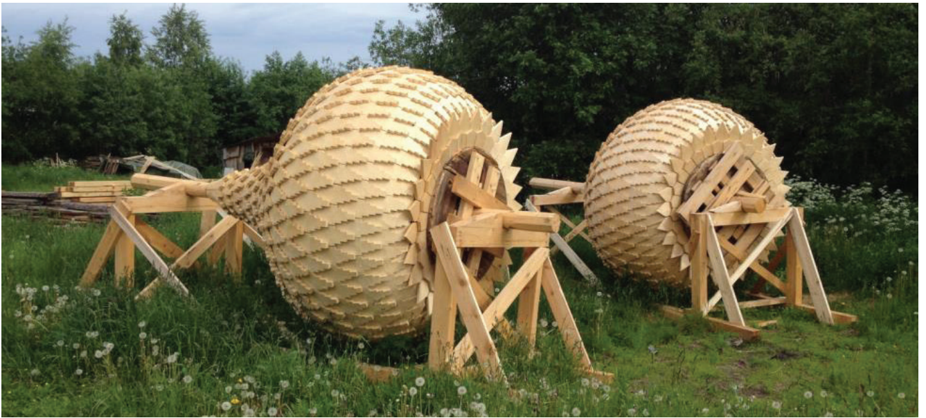
Рис. 32. Отреставрированные главки 3-го реставрационного пояса
