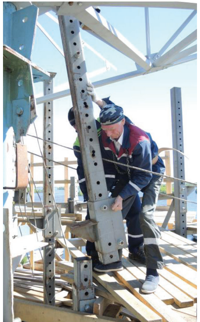
Рис. 9. Демонтаж элементов системы лифтинга
