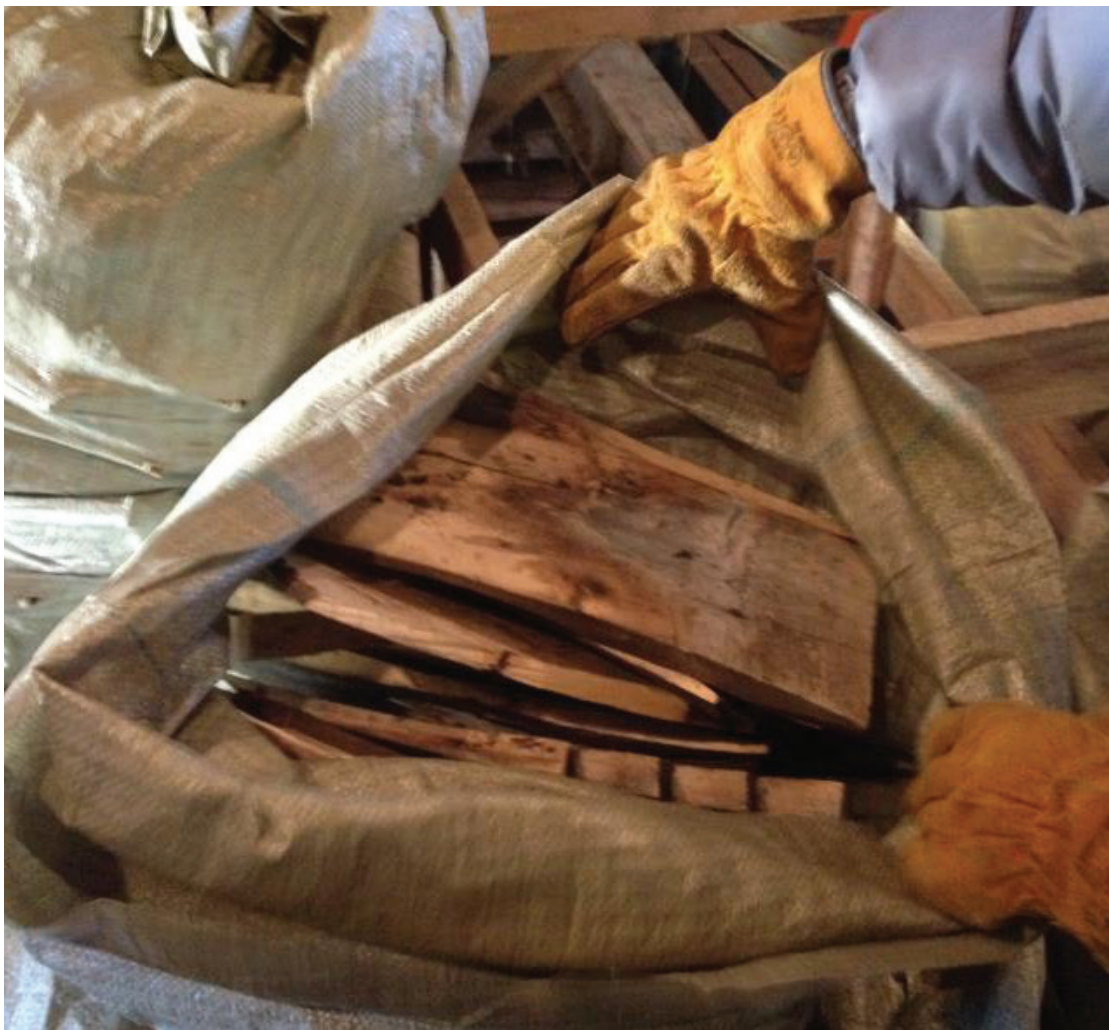
Рис. 6. Демонтированный лемех
