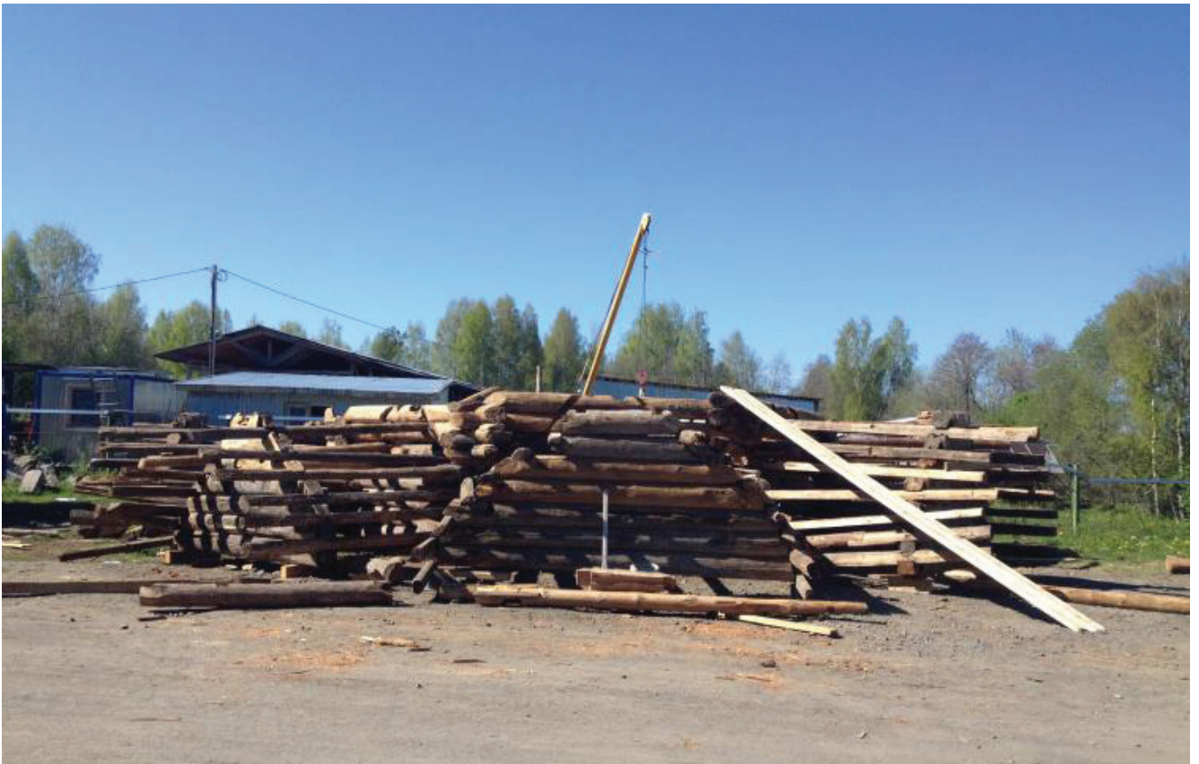
Рис. 24. Предварительная сборка 2-го реставрационного пояса на территории Плотницкого центра
