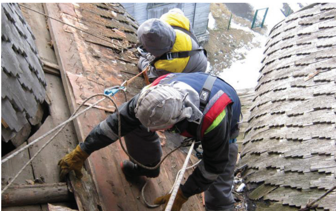
Рис. 2. Демонтаж элементов бочки
