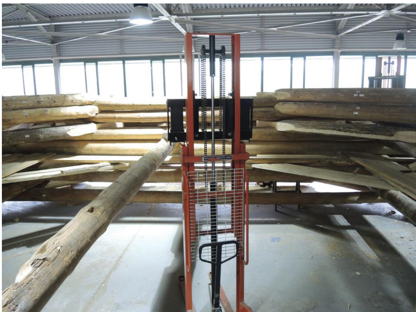
Рис. 19. Сборка балочных конструкций 3-го реставрационного пояса в сборочном цехе
