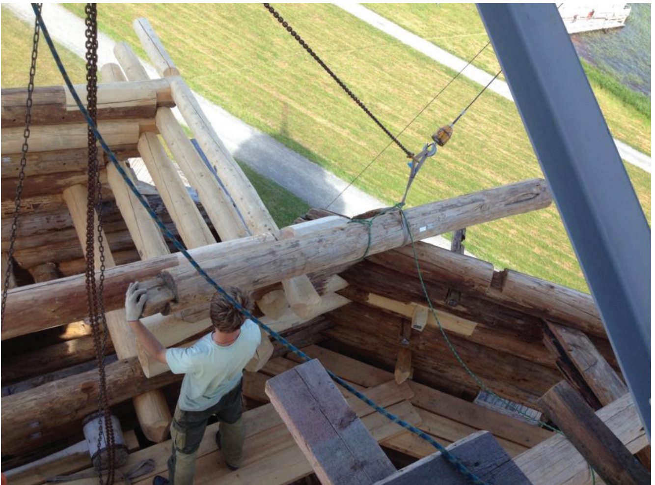
Рис. 21. Сборка сруба 3-го реставрационного пояса на погосте. Подъем элементов
