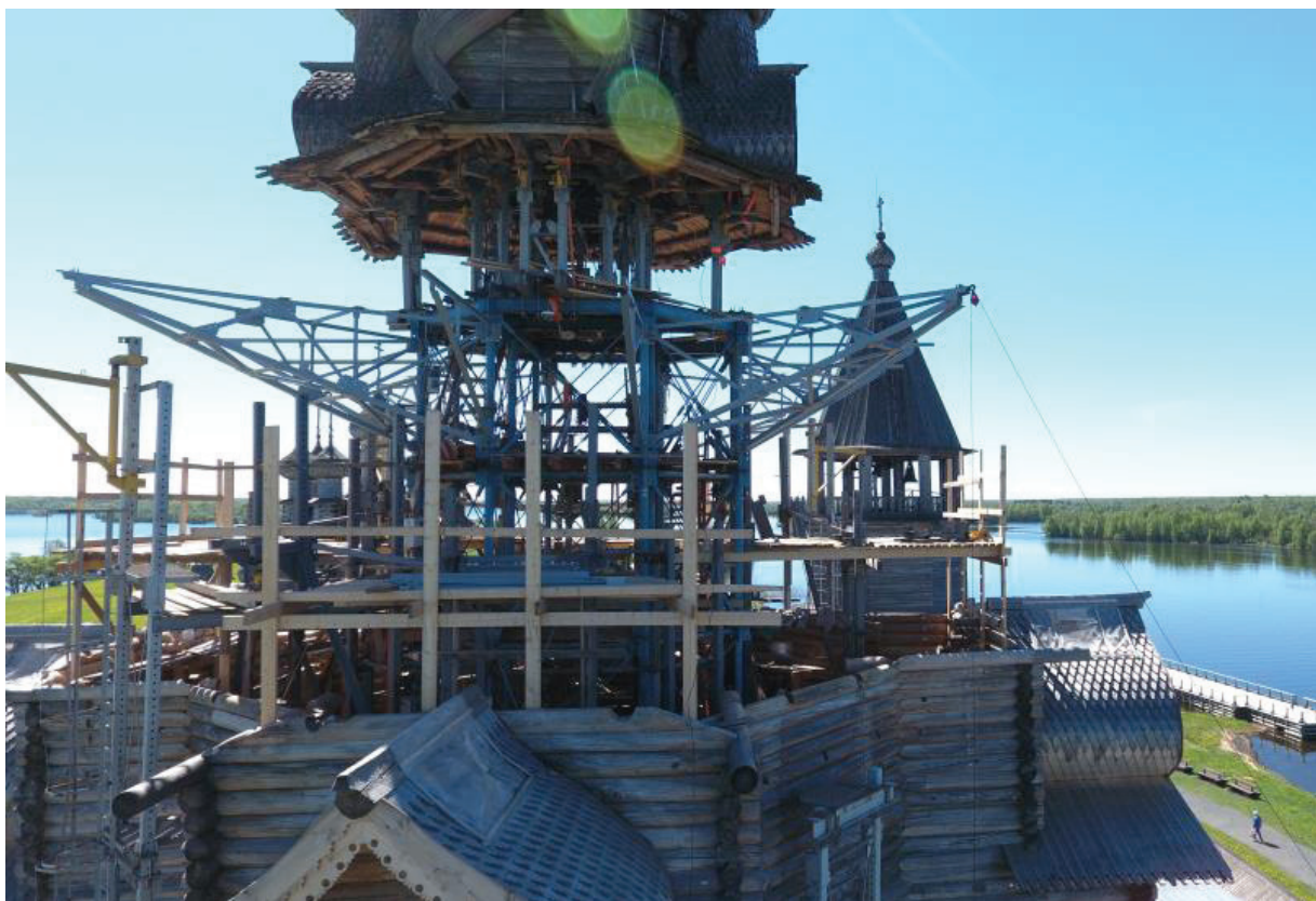
Рис. 12. Система кронштейнов для ведения работ по разборке 1-го реставрационного пояса и сборке 3-го реставрационного пояса
