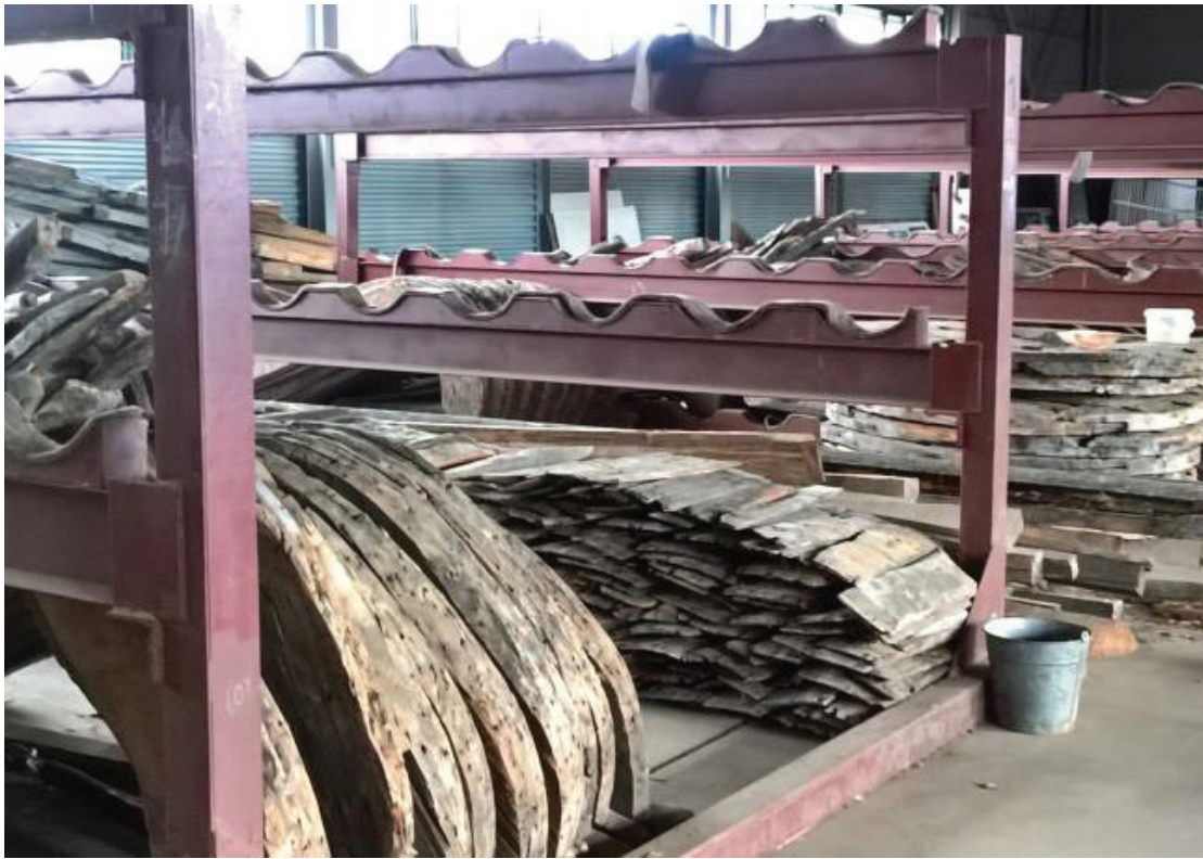
Рис. 5. Демонтированные элементы главок на складе
