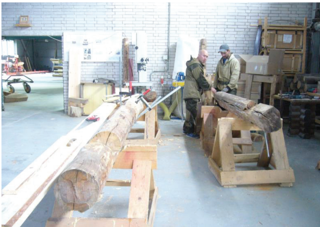
Рис. 27. Реставрация элементов сруба 2-го реставрационного пояса в Реставрационном комплексе
