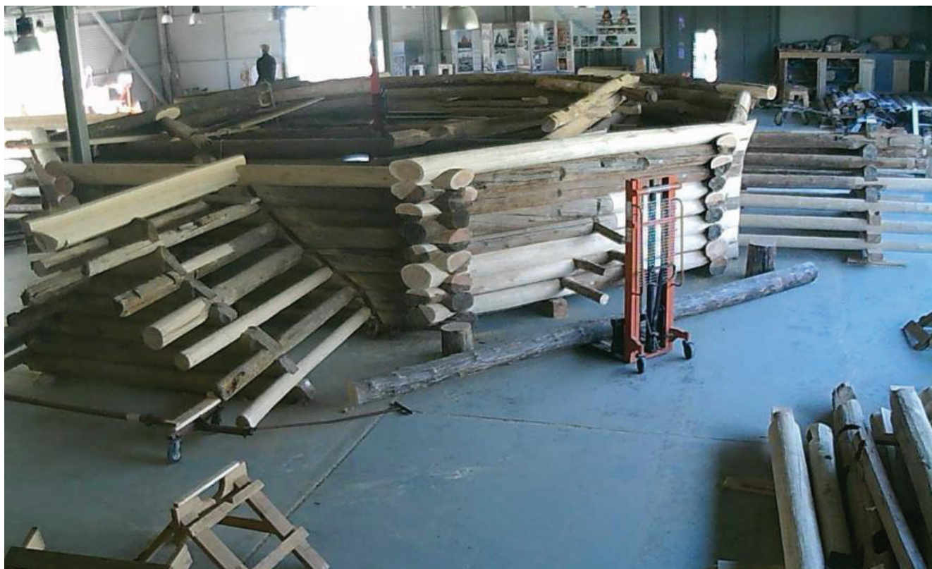
Рис. 18. Реставрационная сборка верхней части сруба 3-го реставрационного пояса в цехах
