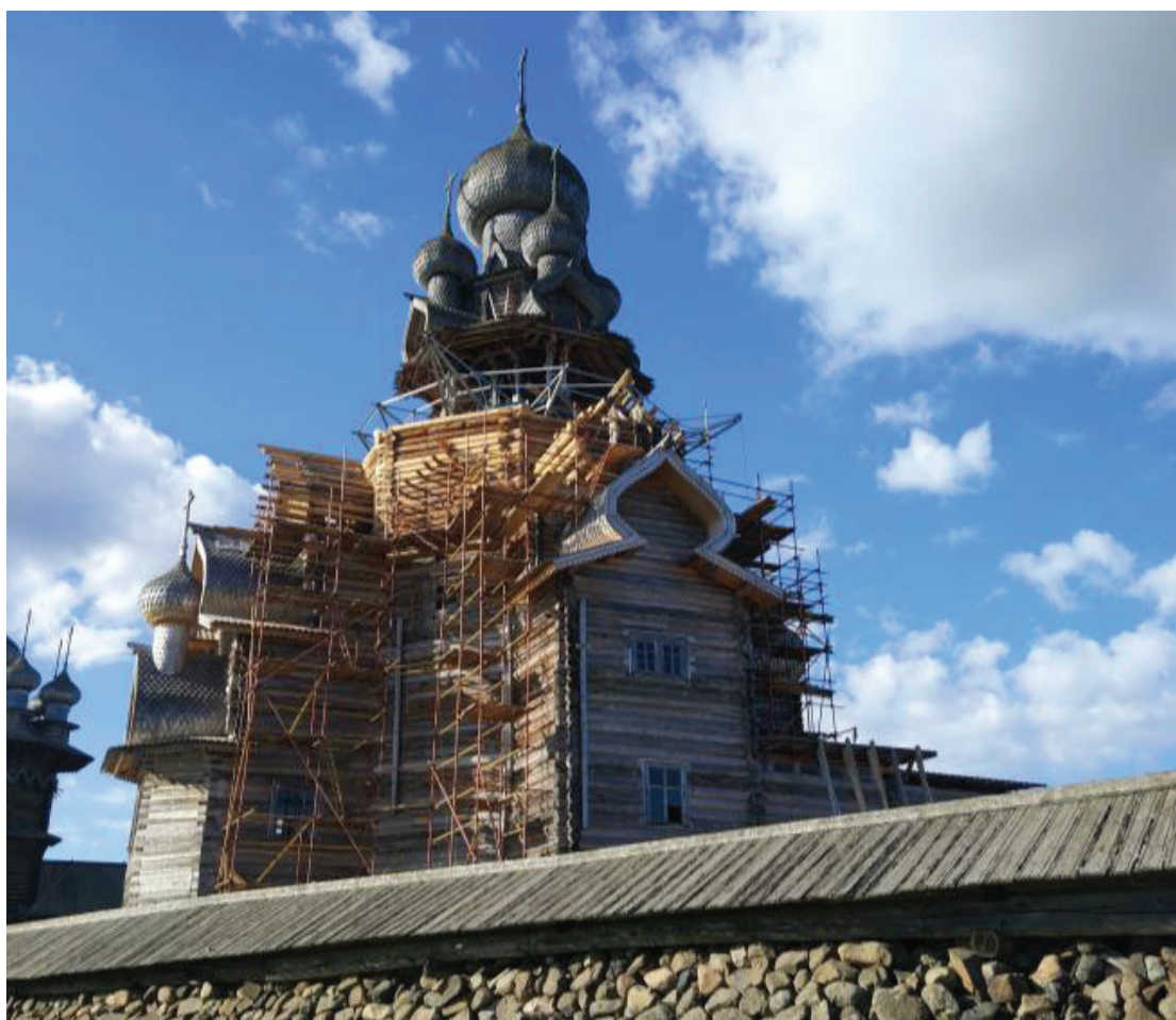
Рис. 34. Монтаж строительных лесов для выполнения работ по окрытию бочек 3-го реставрационного пояса
