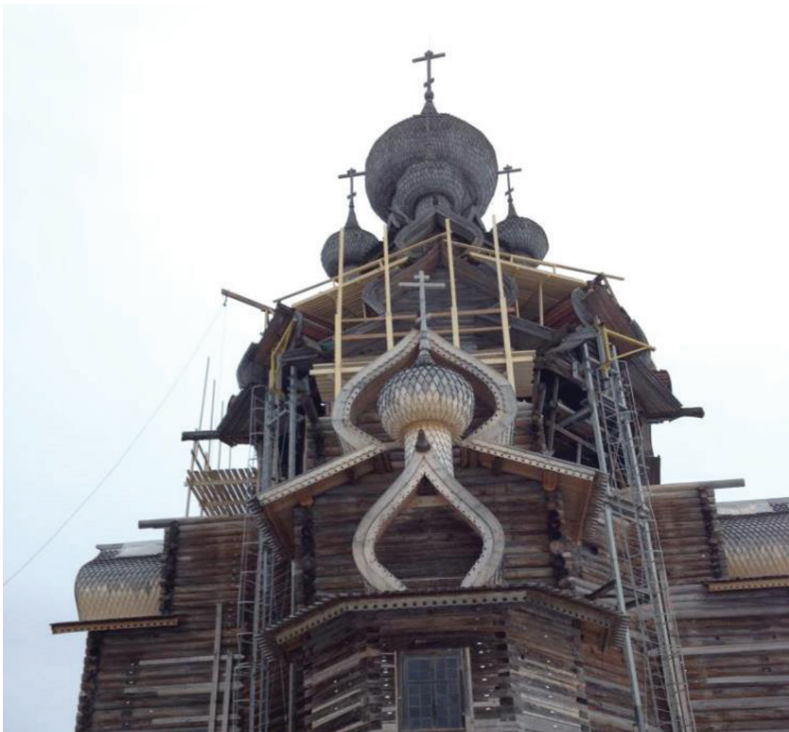
Рис. 4. Технологические леса и подмости для демонтажа конструкций сруба
