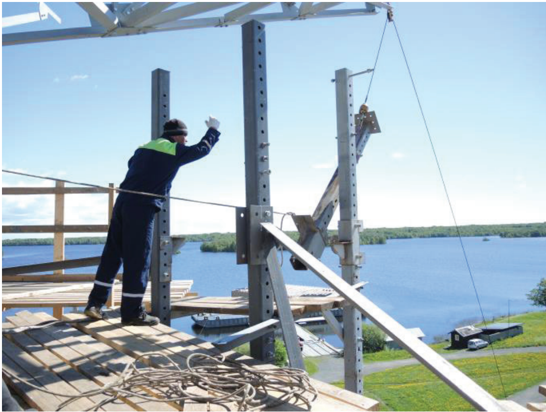
Рис. 10. Спуск демонтированных элементов металлоконструкций
