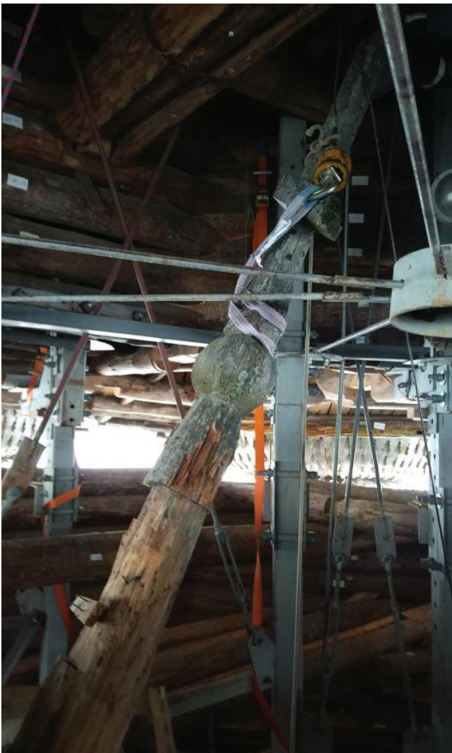
Рис. 8. Спуск демонтированного элемента главки (крест)
