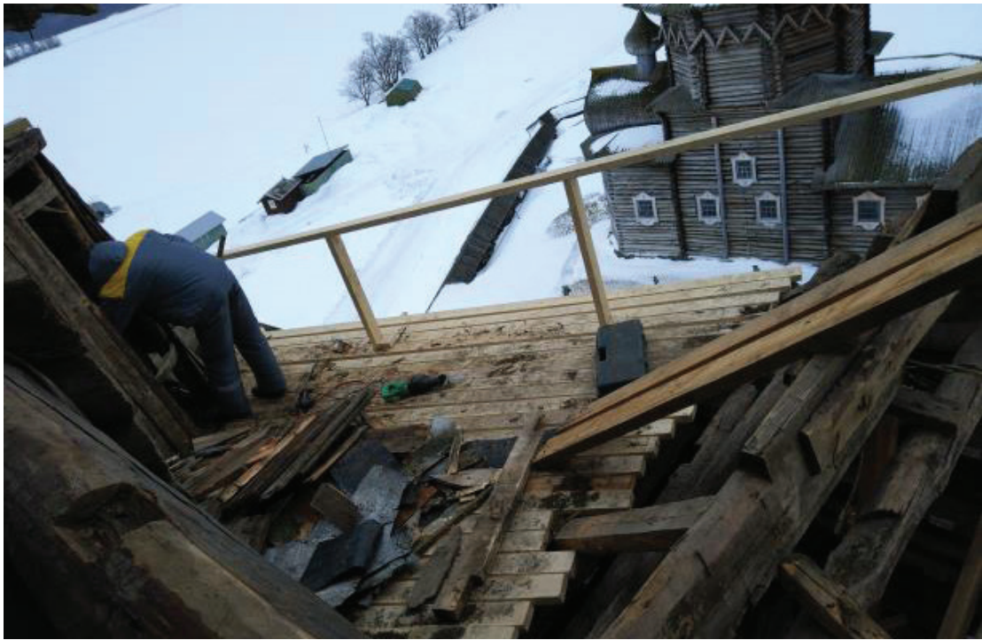
Рис. 7. Разборка барабана главки с технологического помоста
