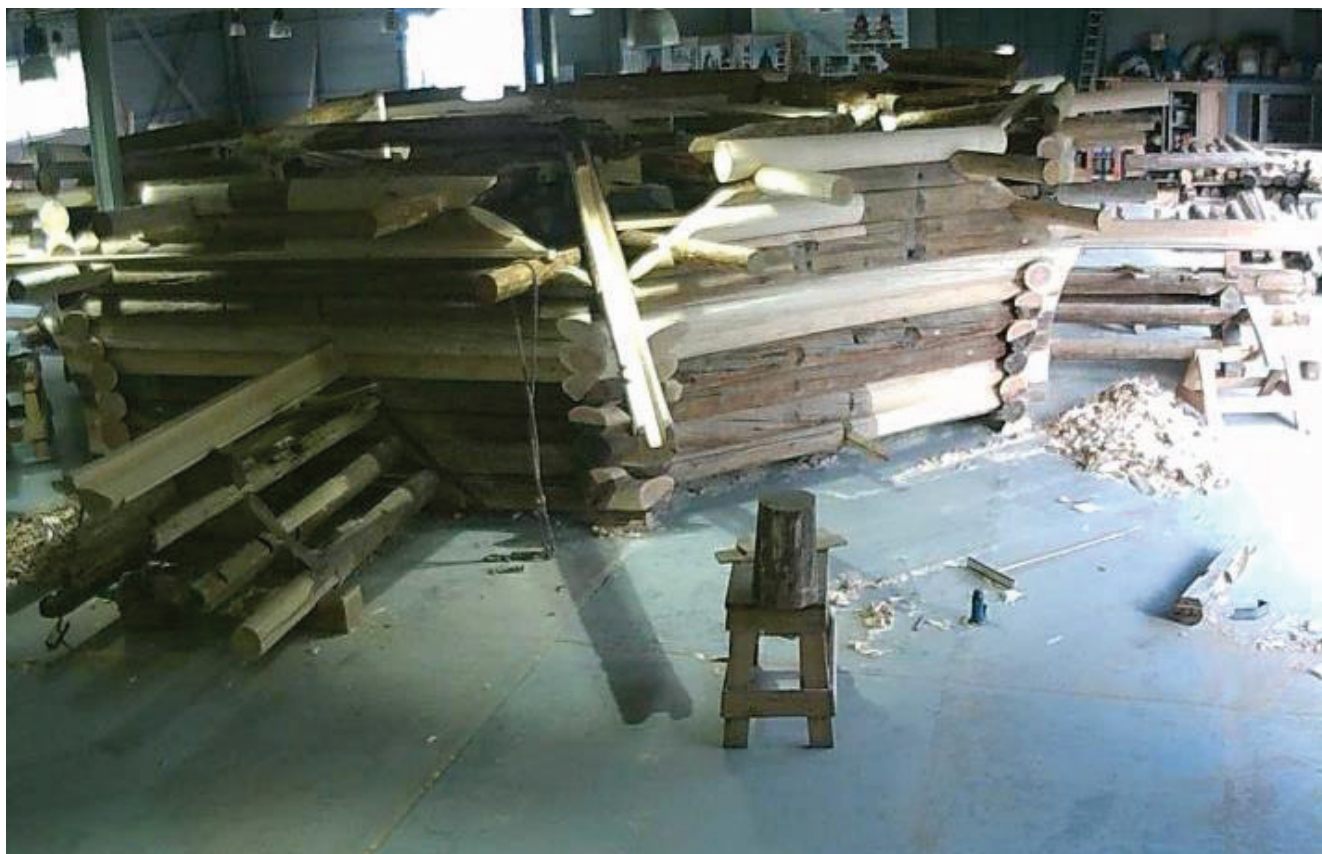
Рис. 26. Реставрационная сборка 2-го реставрационного пояса
