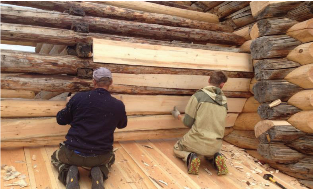
Рис. 30. Сборка южной главки 2-го реставрационного пояса. Монтаж обрешетки
