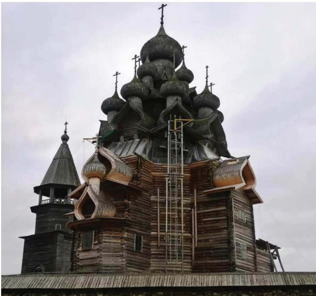
Рис. 1. Церковь в начале реставрационных работ. 2016—2017 гг.
