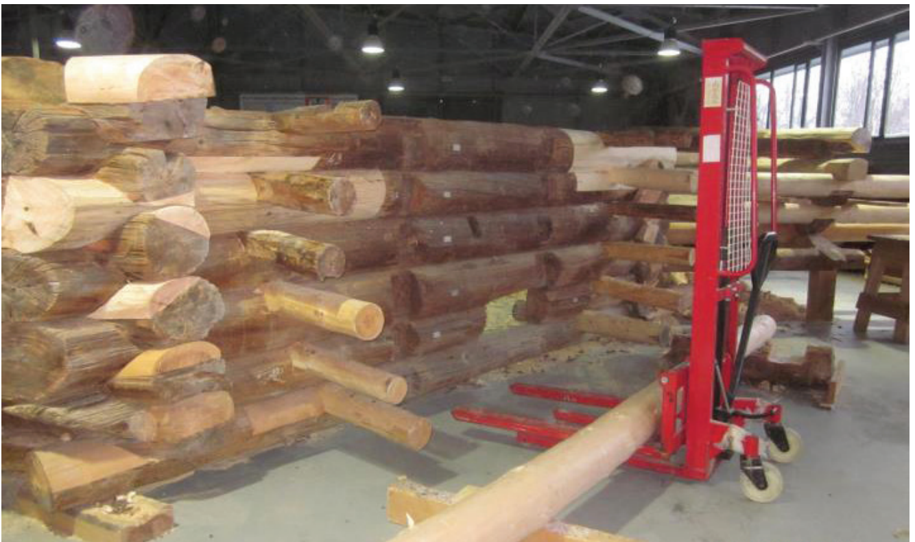
Рис. 17. Реставрационная сборка нижней части сруба 3-го реставрационного пояса в цехах
