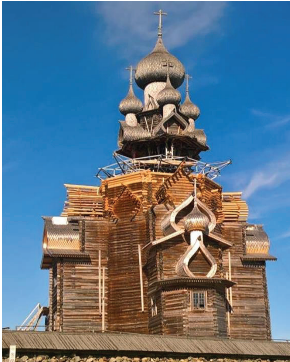
Рис. 33. Завершение работ по сборке сруба 3-го реставрационного пояса на погосте
