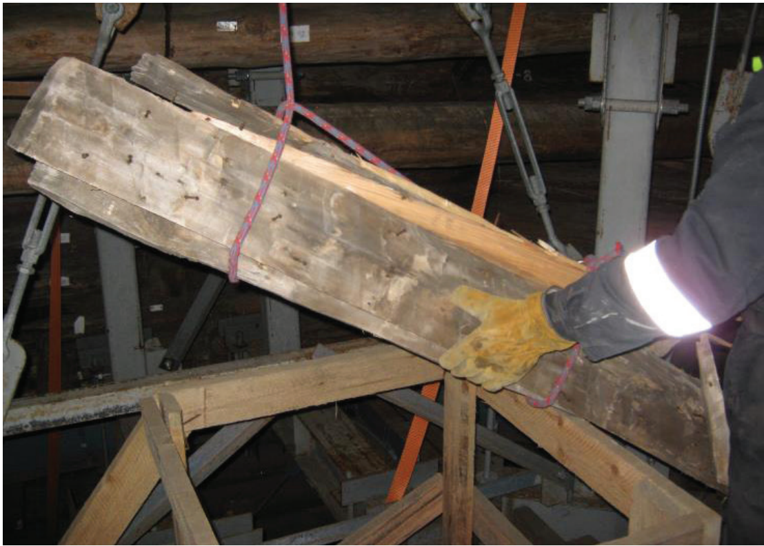
Рис. 3. Спуск демонтированных элементов кровли
