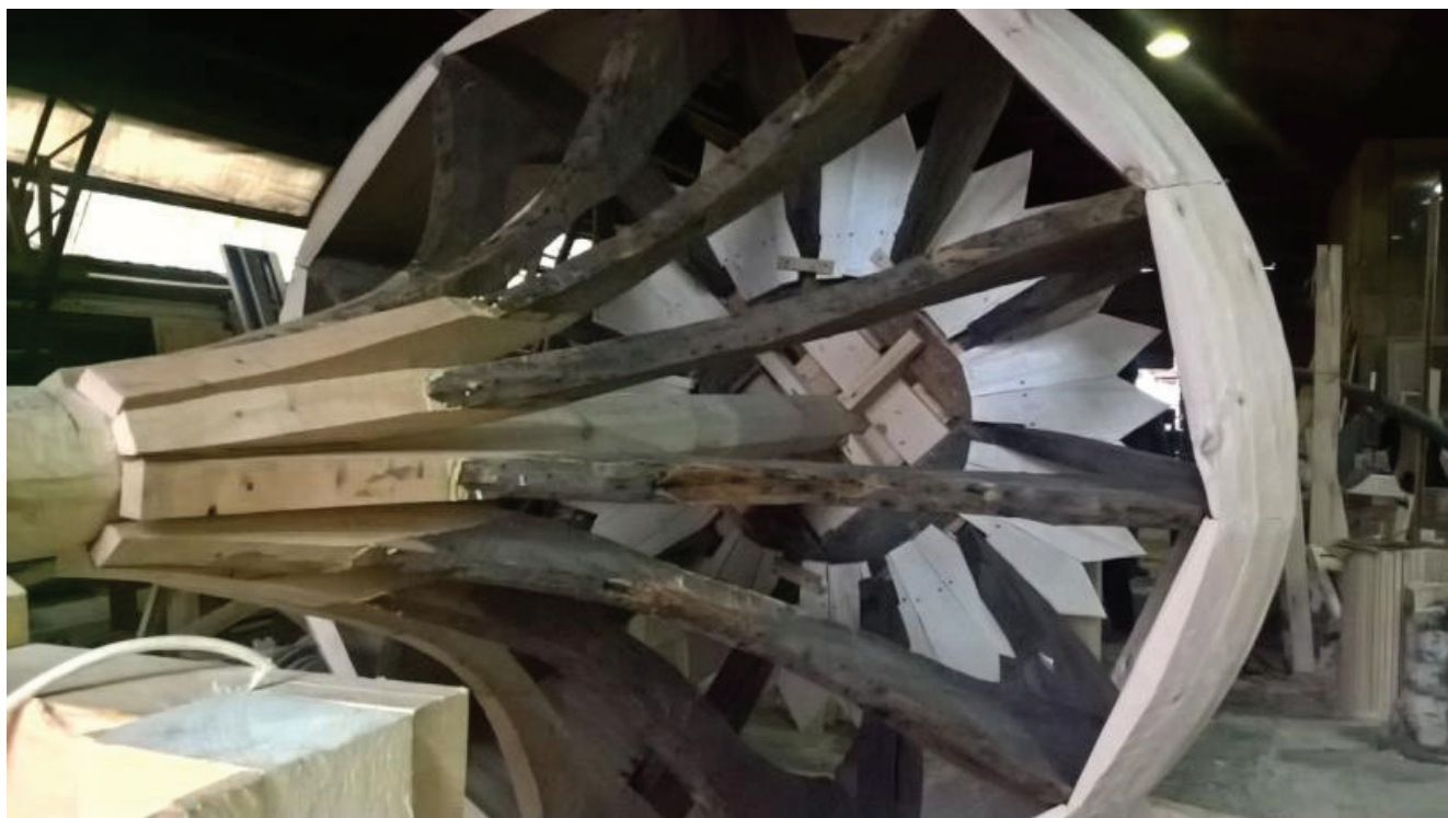
Рис. 30. Сборка южной главки 2-го реставрационного пояса. Монтаж обрешетки
