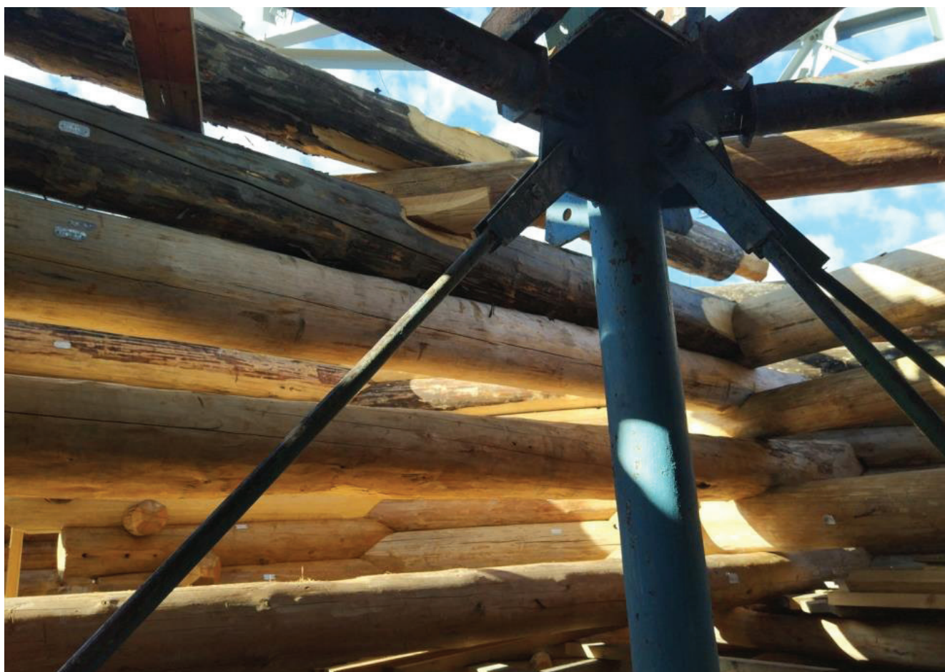
Рис. 23. Сборка 3-го реставрационного пояса на погосте. Чтвериковые балки
