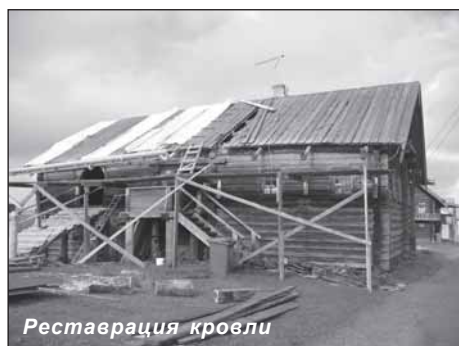
Укладка гидроизоляции
