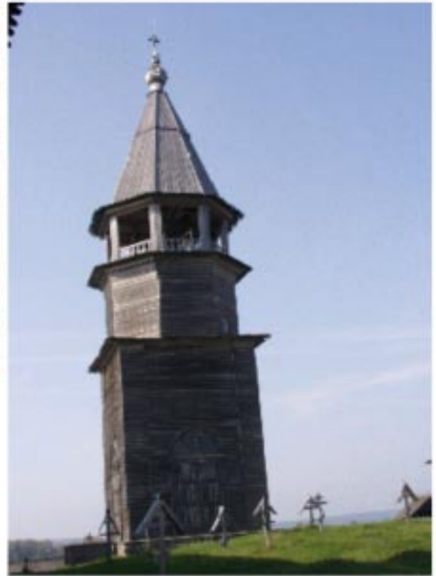
2. Колокольня. Южный фасад
