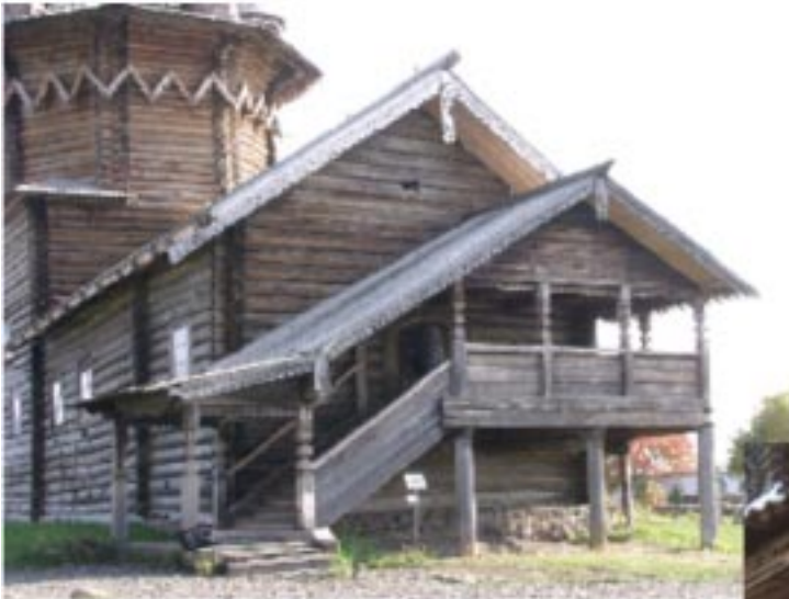
3. Крыльцо Покровской церкви
