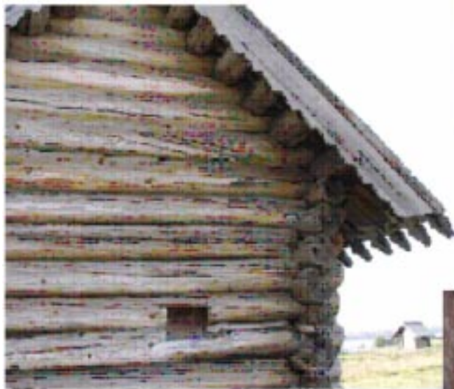
3. Церковь Воскрешения Лазаря. Подкровельные слепи, волоковое окно (вид снаружи)
