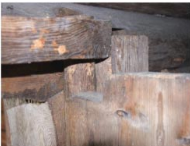
7. Интерьер церкви Воскрешения Лазаря: поворотный узел двери («опята» и «огнездо»)
