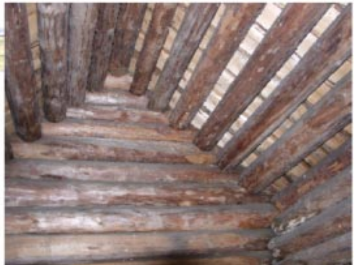
4. Интерьер церкви Воскрешения Лазаря: подкровельные слепи в алтарном прирубке
