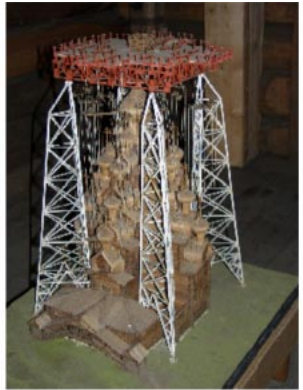
10. Макет Преображенской церкви, силовые стойки и платформы (к проекту реставрации, предложенному ЛИСИ. 1972 г.)
