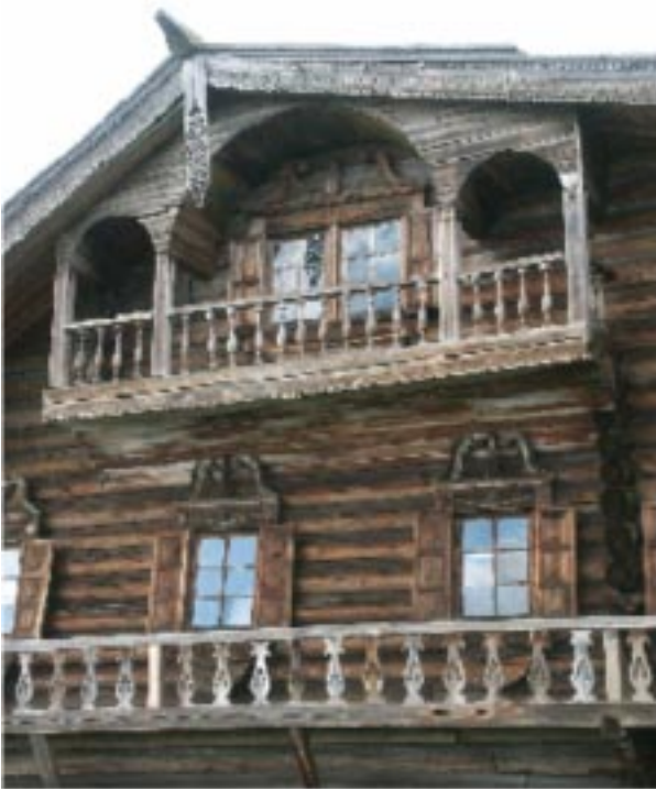
3. Дом Ошевнева. Южный фасад
