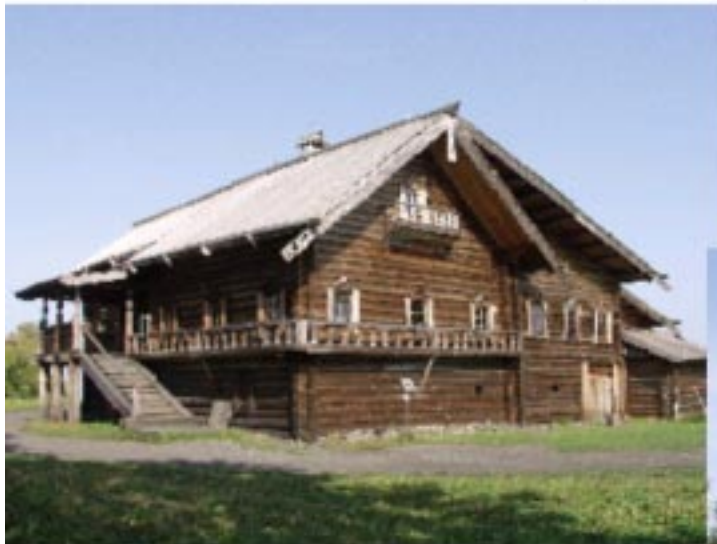
1. Дом Елизарова. Вид с юго-запада
