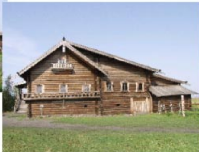
2. Дом Елизарова. Южный фасад
