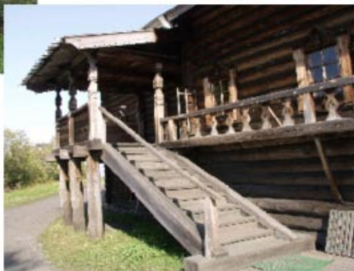
4. Крыльцо дома Елизарова
