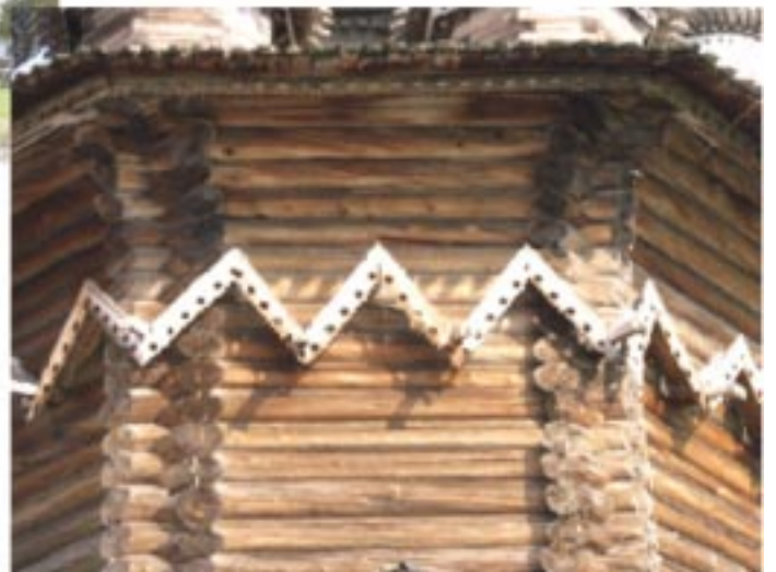
4. Покровская церковь: фронтоный пояс
