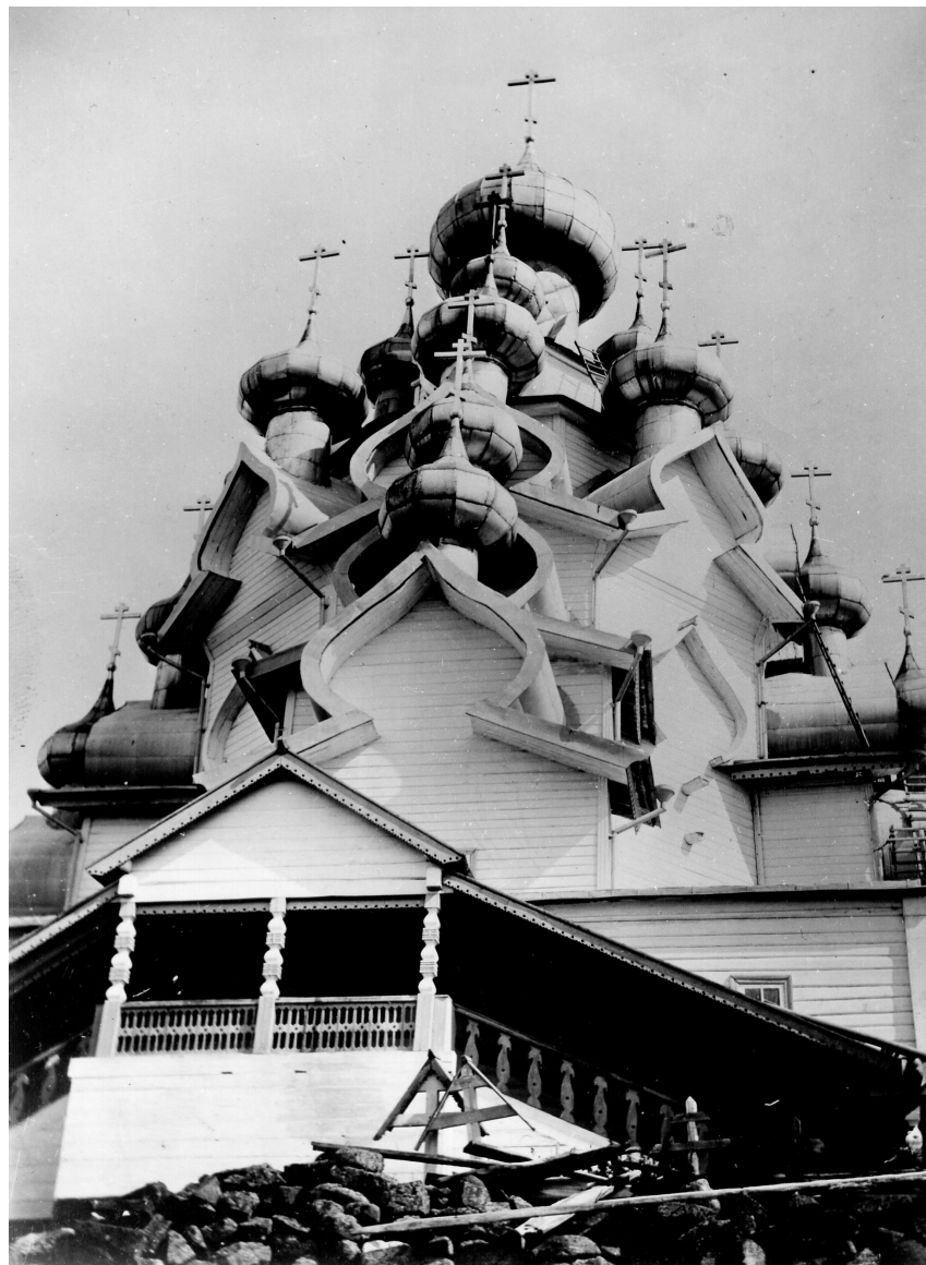
Рис. 1. Кижский погост. Преображенская церковь. Вид с крыльца. Фото И. Билибина, 1903–1904 гг.
