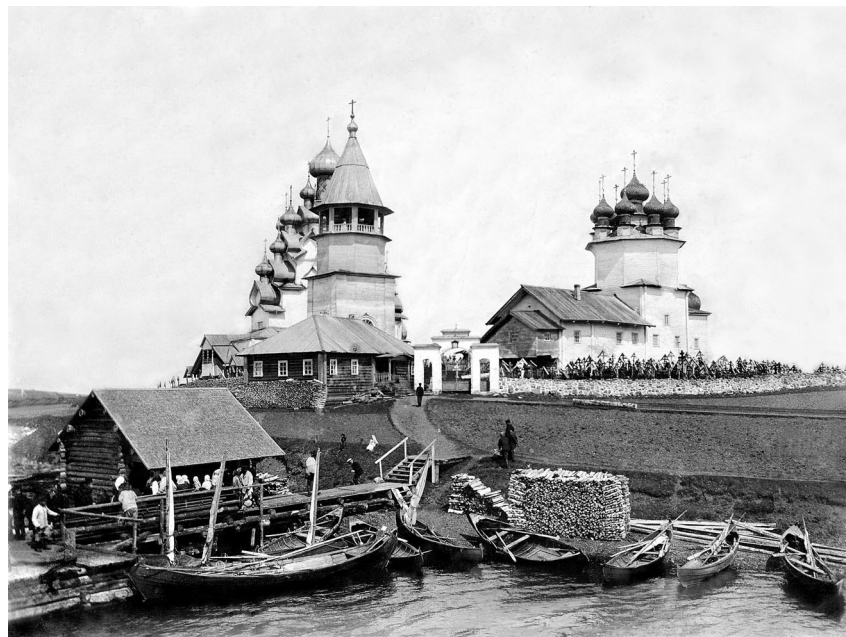
Рис. 4. Главный причал о. Киж (фотография из архива музея «Киж»)
