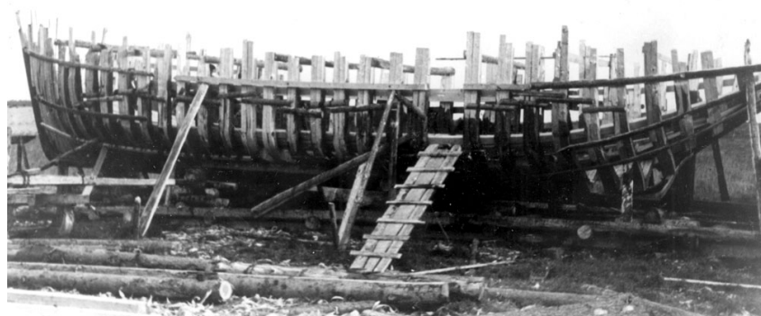
Рис. 3. Строительство моторбота на стапеле Волкостровской судовой верфи (фотография из архива Музея архитектуры им. Щусева)
