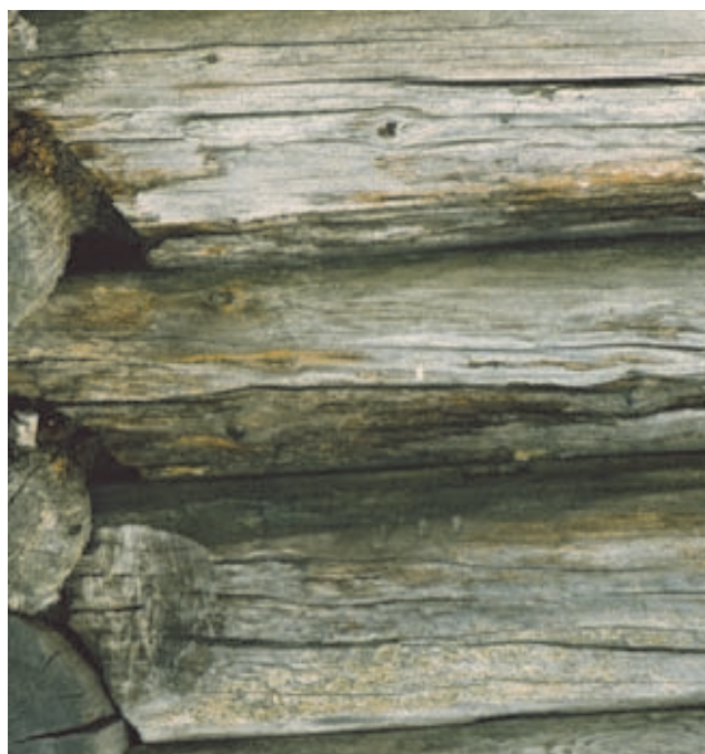
Рис. 3 Поражение внешней поверхности бревен умеренной гнилью
