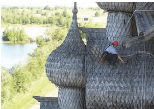
Рис. 7. Очистка лемехового покрытия от мха
