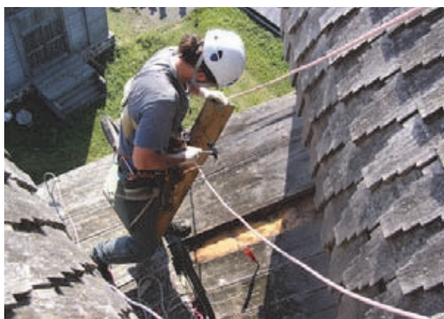
Рис. 6. Консервация кровель с использованием метода промышленного альпинизма
