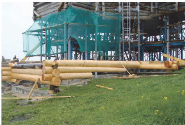
Нижние каскадные венцы церкви и железобетонный фундамент
