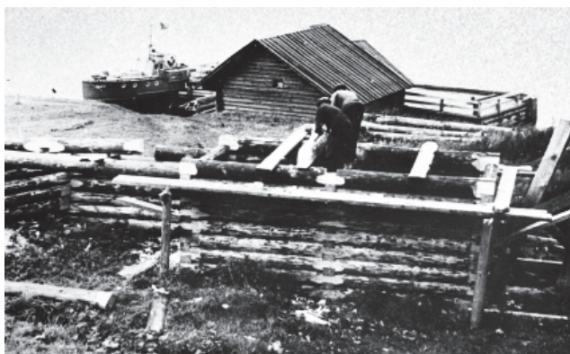
Рис. 8. Ограда в процессе реставрации. Начало 1950-х гг. Ополовников А. В. НВФ 3880
