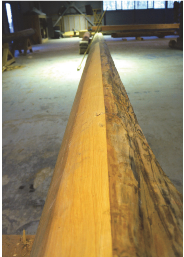
Вставка из выдержанной древесины в оригинальном бревне
