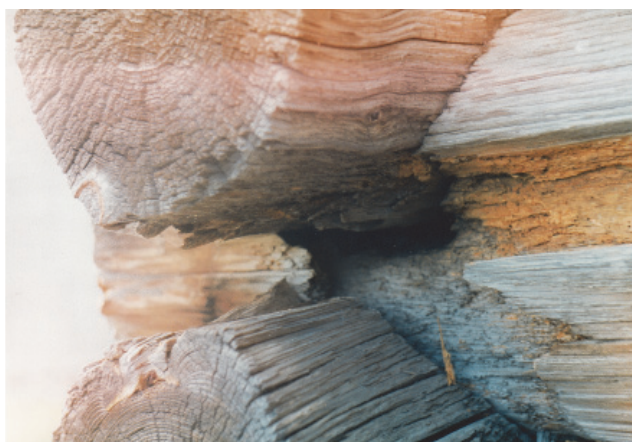
Рис. 7. Следы жизнедеятельности домового точильщика на поверхности бревен Преображенской церкви
