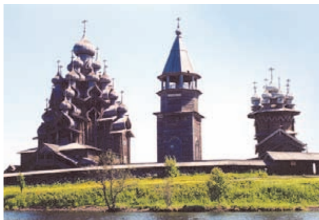
Рис. 26. Кижский архитектурный ансамбль. 2001 г. Вид с юго-запада (с озера). Семененко О. А. НВФ 14172/7
