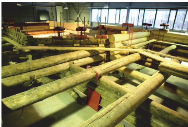
Часть отреставрированного и обжатога в уровне балок 7-го пояса в цеху (вид сверху)
