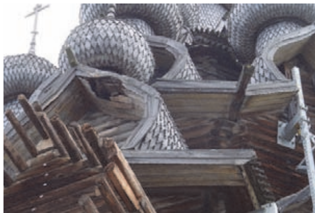
Вид на одну из бочек со следами от «невлезающей» главки
