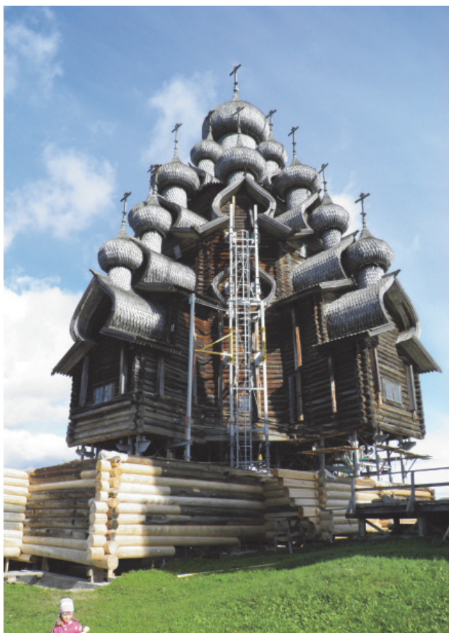
Вывешенный храм Преображения с собранным 7-м и частью 6-го пояса
