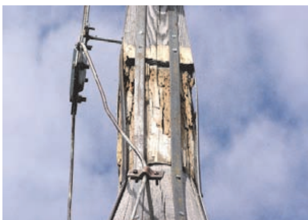
Рис. 8б. Укрепление креста центральной главы
