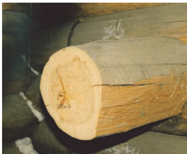
Рис. 2. Бревно в интерьере Преображенской церкви, которое после многолетней эксплуатации сохранило свои прочностные свойства
