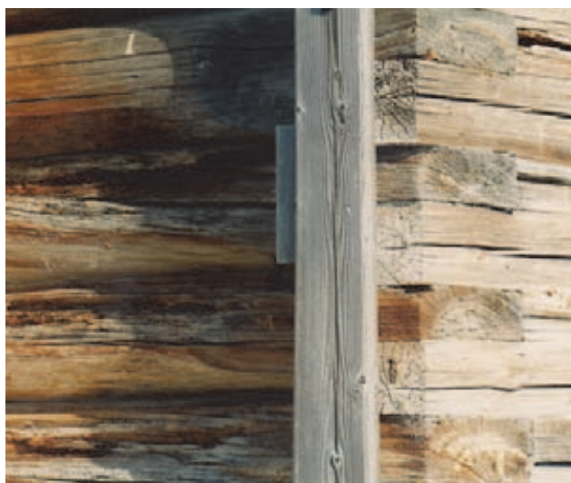
Рис. 4. Разрушение верхней четверти бревна, вызванное грибом Coniophora puteana (Fr.)
