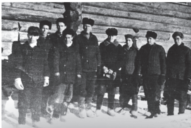
Рис. 29. Бригада плотников-реставраторов на реставрации Покровской церкви. Слева направо 1-й ряд: Федосов А. И., Афонин А. И., Елунов Б. Ф., Мышев М. К., Мотов И. М. 2-й ряд: Никитин В. М., Елизаров К. Ф., Никитин Д. М. 1950-е гг. Ополовников А. В. НВФ 3931
