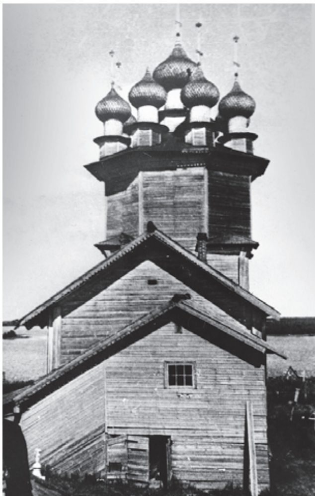
Рис. 7. Покровская церковь до реставрации. Начало 1950-х гг. Вид с запада. Ополовников А. В. НВФ 3889
