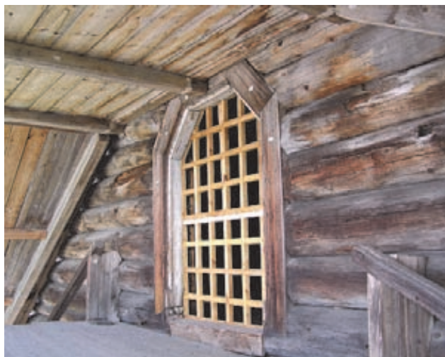
Рис. 10. Вентиляционная решетка на входе в трапезную церкви
