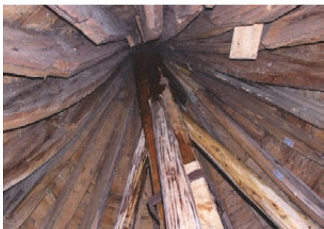
Рис. 4. Протечка в зоне осевого столба центральной главы, обнаруженная в процессе мониторинга
