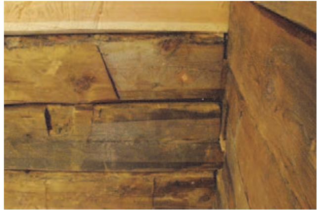
Следы от первоначальной протески углов
