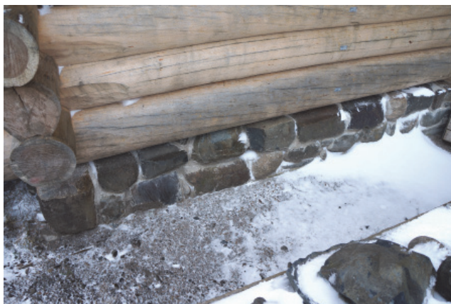
Каменная кладка фундамента на известковом растворе
