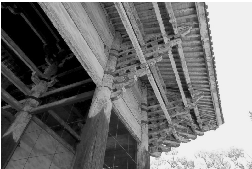
Рис. 2. Конструкция консоли (доугун) на храме в Японии
