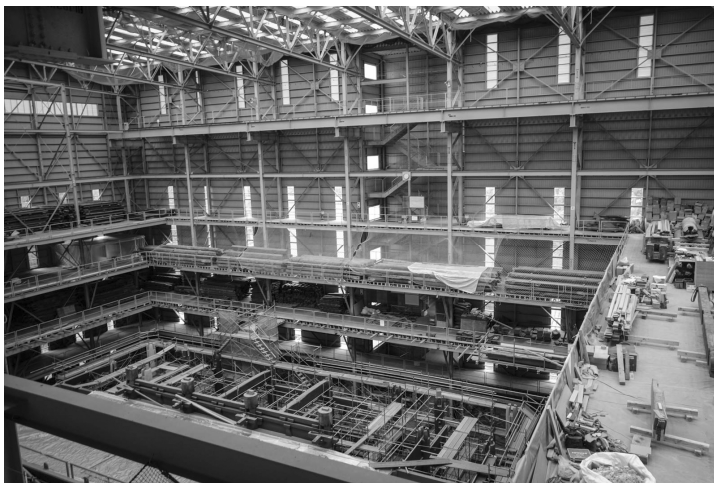
Рис. 4. Организация реставрационных работ в Японии
